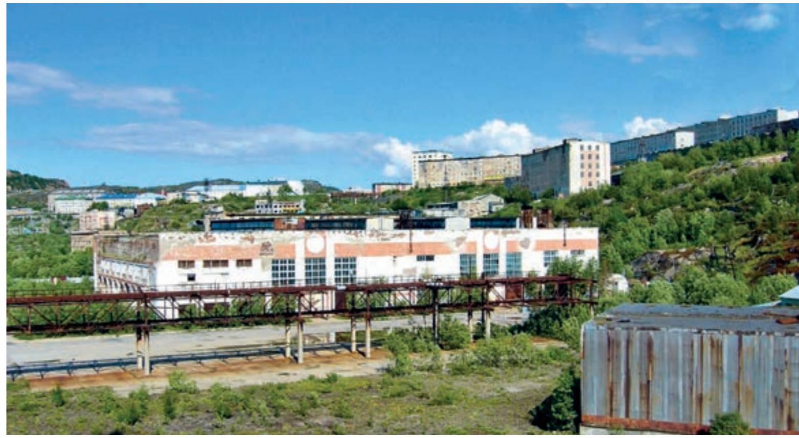
Цех №10, ранее комплексное электромонтажное производство, ныне здание «свободной планировки»
