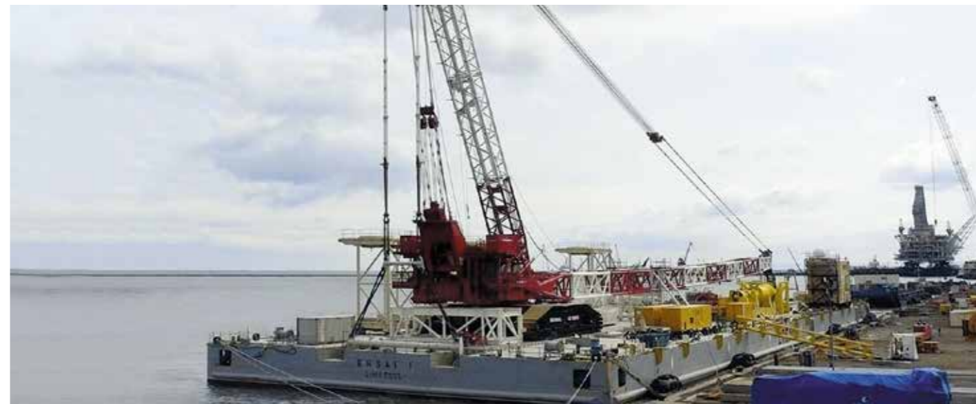
СТРОИТЕЛЬНАЯ БАРЖА ПРОЕКТА ERSAI 1
